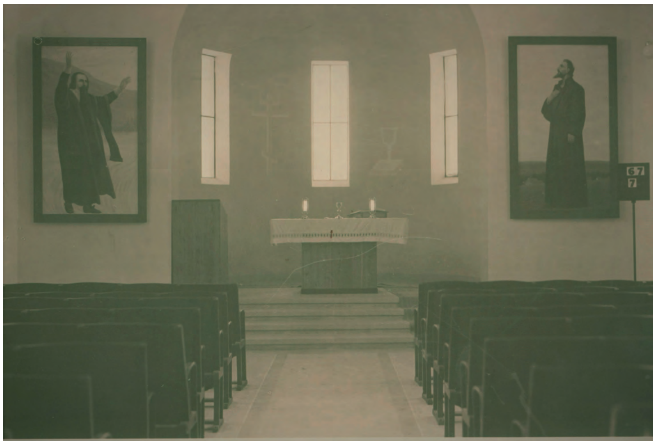
Interiér Husova sboru v Jílovém u Prahy s původními obrazy J. Husa a J. A. Komenského – foto ÚAM CČSH.
